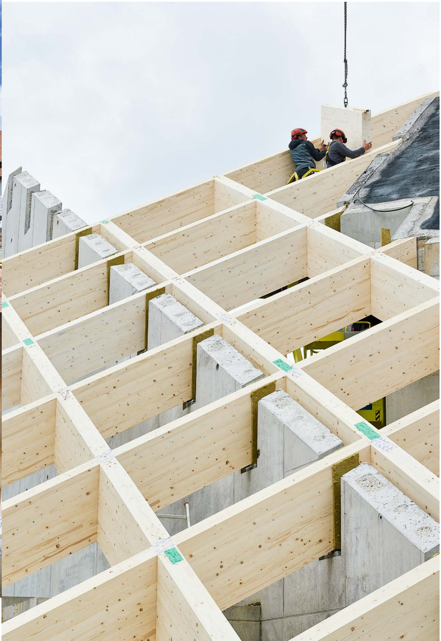
Das Siedle Haus kurz vor dem Richtfest. Noch ist die Kassettenkonstruktion nicht geschlossen.
